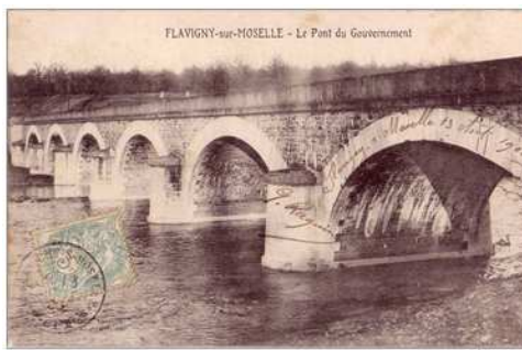
Le Pont du Gouvernement
