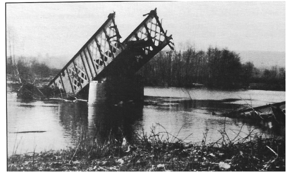
Le Pont de Velle-sur-Moselle détruit le 6 septembre 1944
